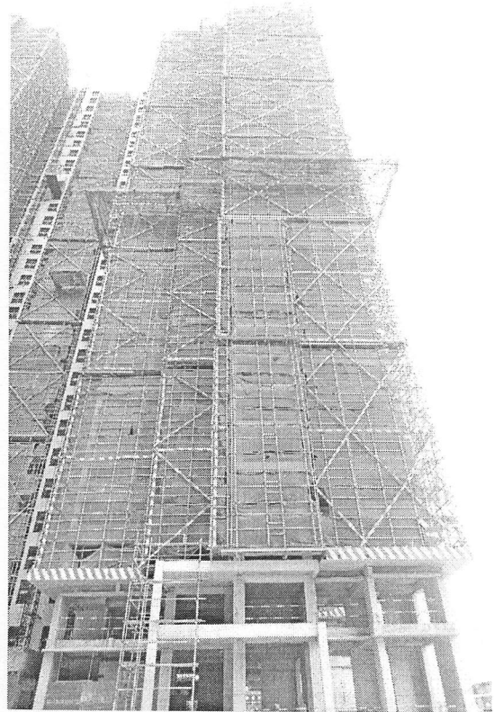
6 栋 (砌砖完成 21 个楼层)
