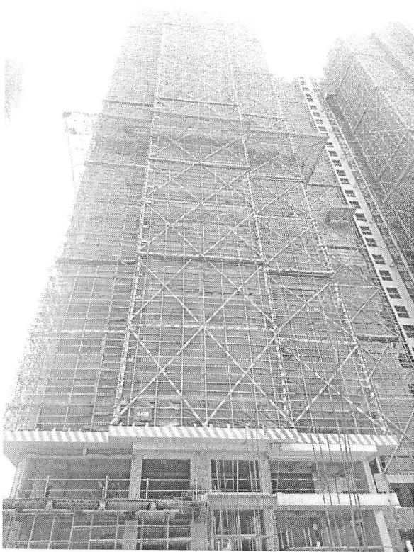
5 栋 (砌砖完成 20 个楼层)
