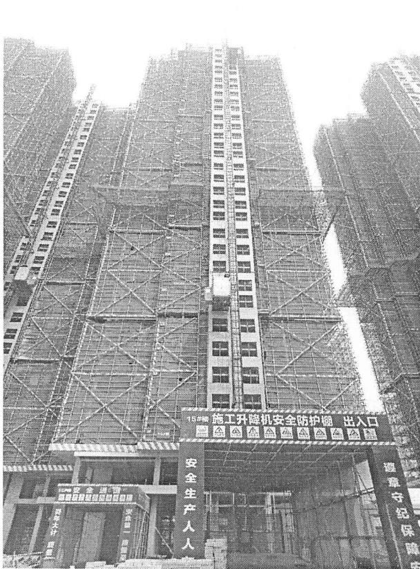
15 栋（砌砖完成 23 个楼层）
