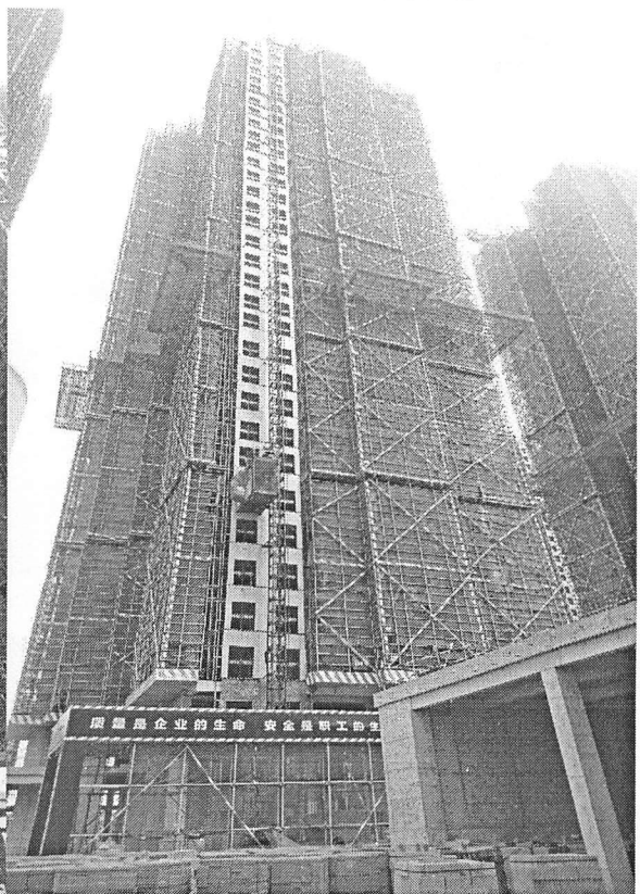
16 栋（砌砖完成 22 个楼层）
