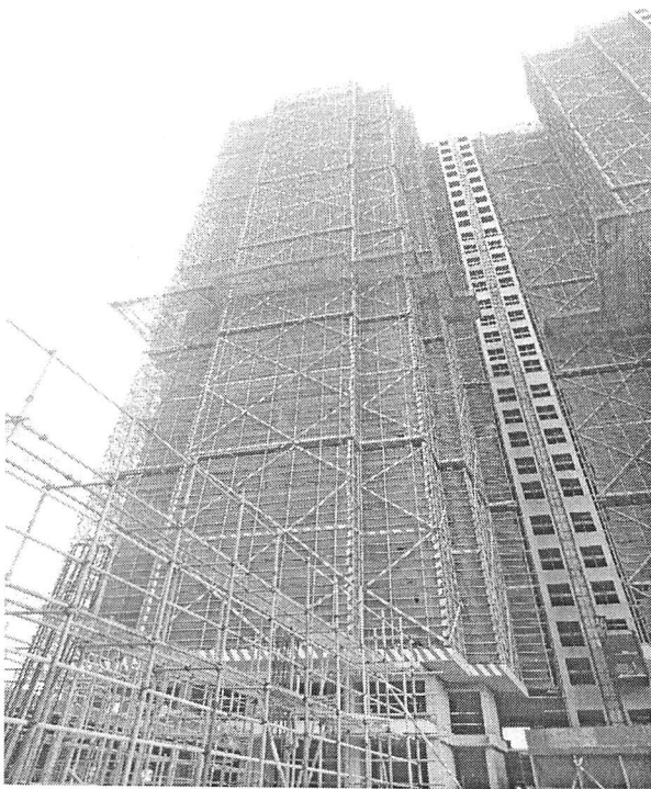
7 栋 (砌砖完成 18 个楼层)
