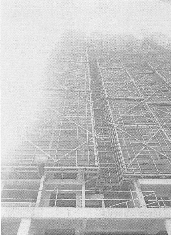
1 栋(砌砖完成 21 个楼层)
