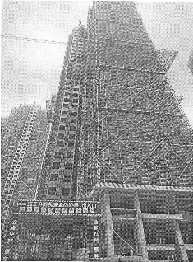
13 栋（砌砖完成 25 个楼层）
