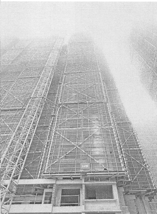
2 栋(砌砖完成 22 个楼层)
