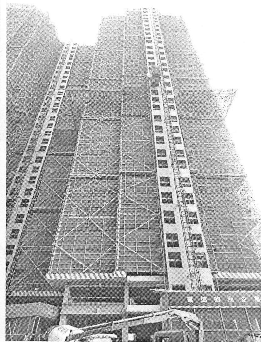
8 栋 (砌砖完成 18 个楼层)
