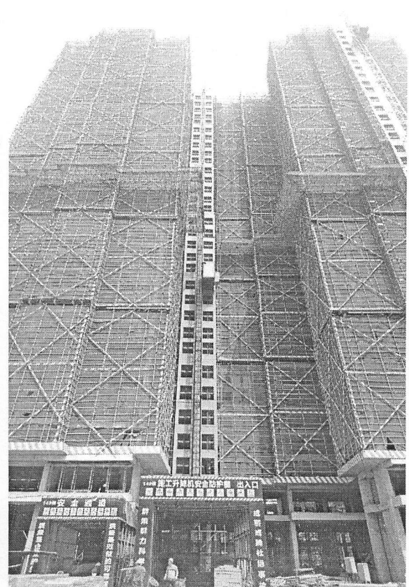
14 栋（砌砖完成 29 个楼层）
