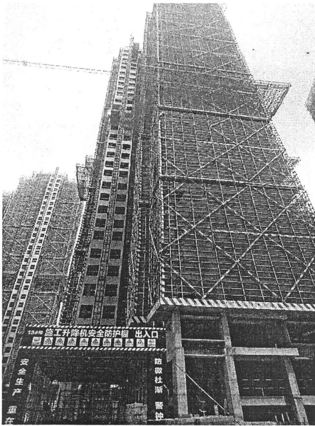
13栋（内、外墙抹灰分别完成8个、10个楼层）
