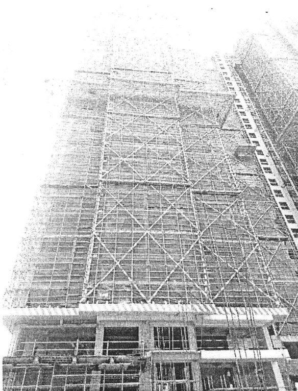
5 栋（内、外墙抹灰分别完成 7 个、10 个楼层）
