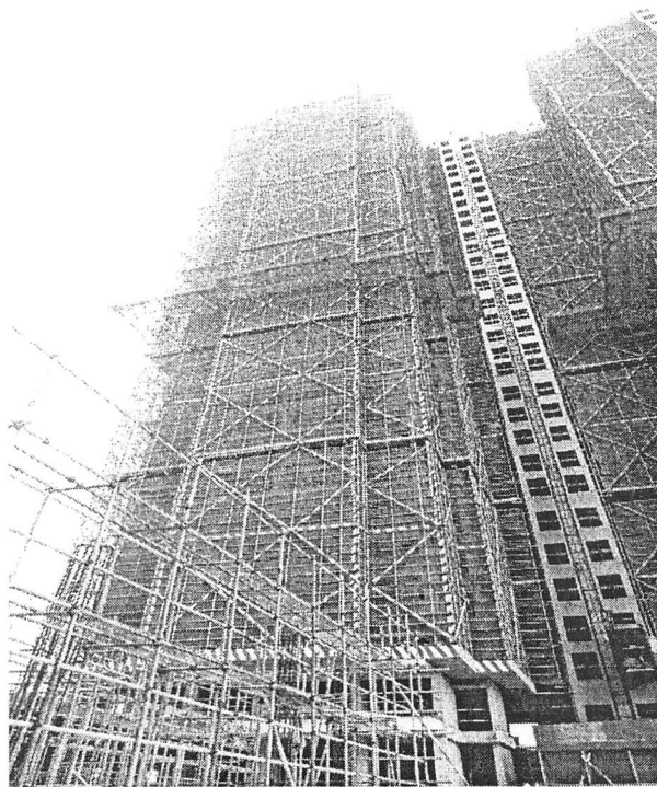
7 栋（内、外墙抹灰分别完成 4 个、7 个楼层）
