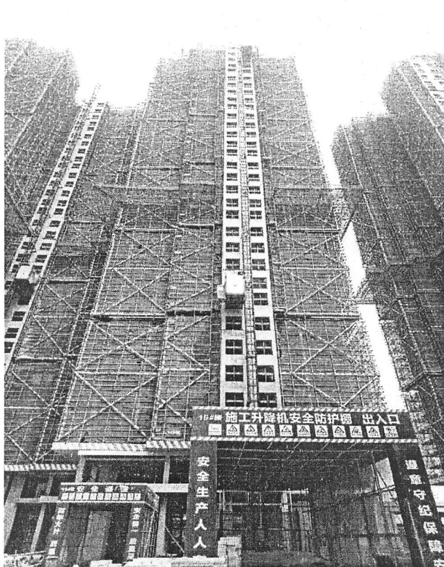
15栋（内、外墙抹灰分别完成11个、11个楼层）
