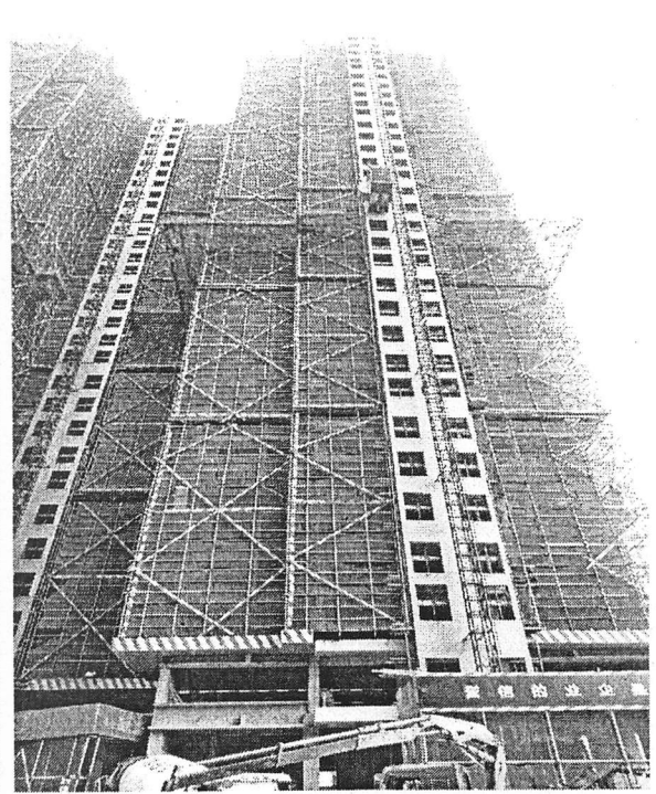
8 栋（内、外墙抹灰分别完成 6 个、10 个楼层）
