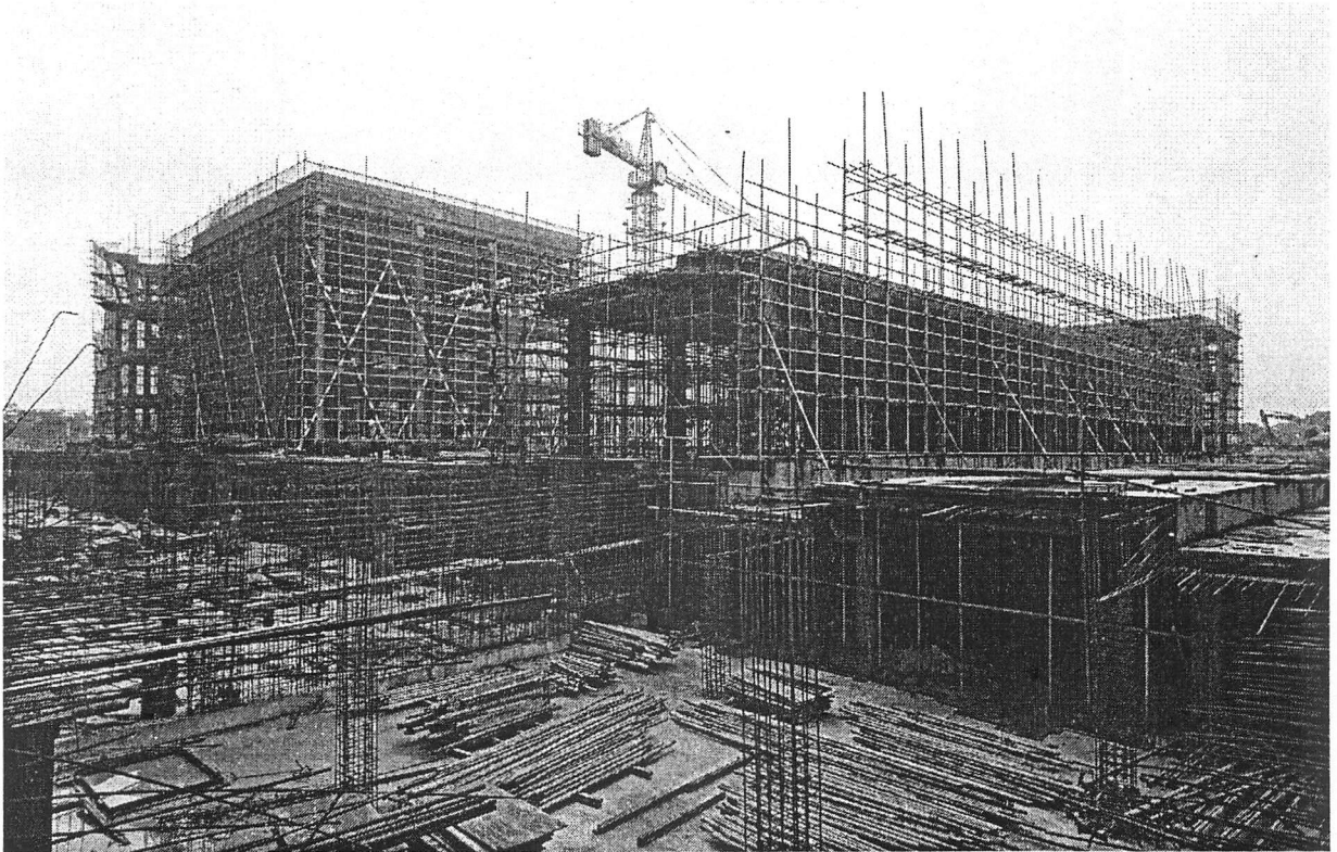
15 区（幼儿园）：地下室外围土方回填完成 50%，2#商铺天面层支模完成 90%。
