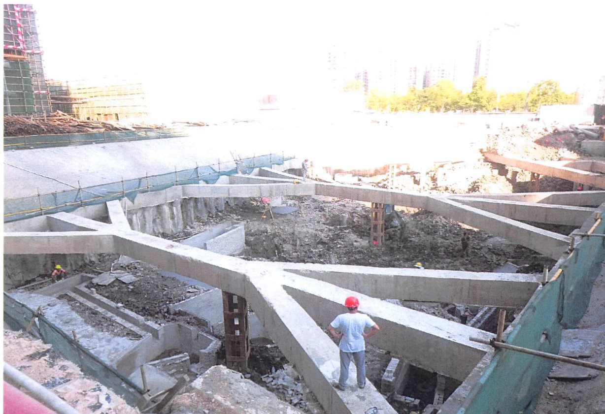
综合楼：塔吊安装完成，承台开挖、砖胎模砌筑完成 40%。
