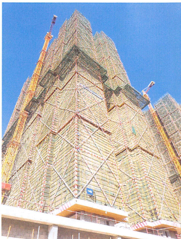
7 栋（内、外墙抹灰分别完成 24 个、17 个楼层）
