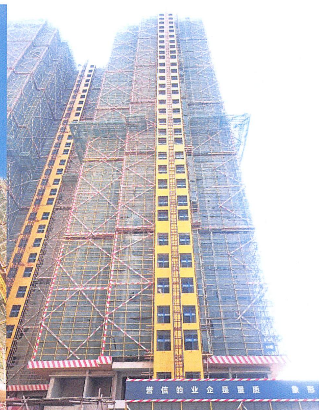
8 栋（内、外墙抹灰分别完成 24 个、23 个楼层）
