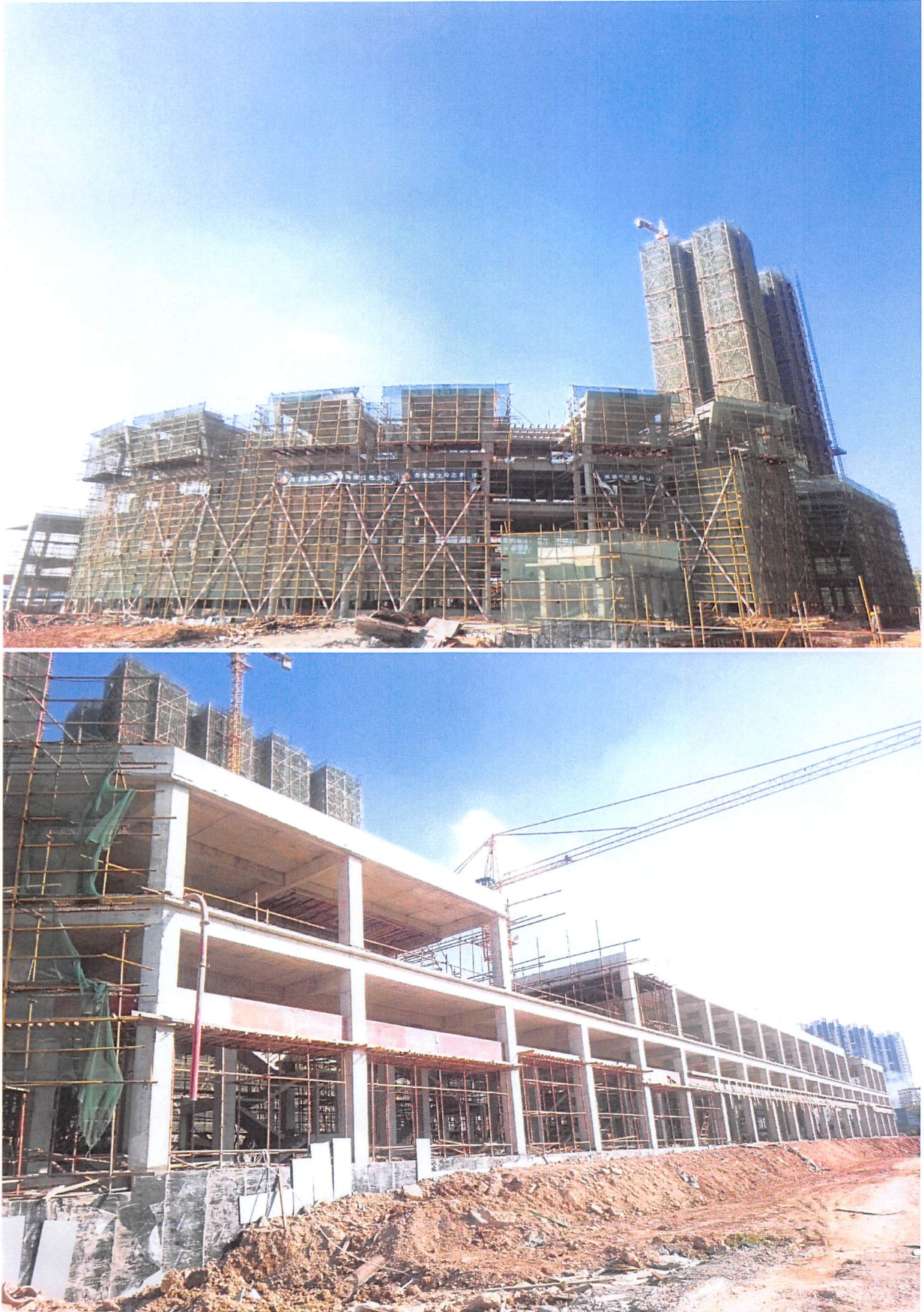
15 区（幼儿园）：2#商铺天面层砼浇筑完成，所有主体结构均完成。
