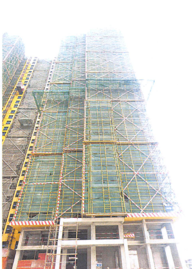
6 栋（内、外墙抹灰分别完成 27 个、22 个楼层）
