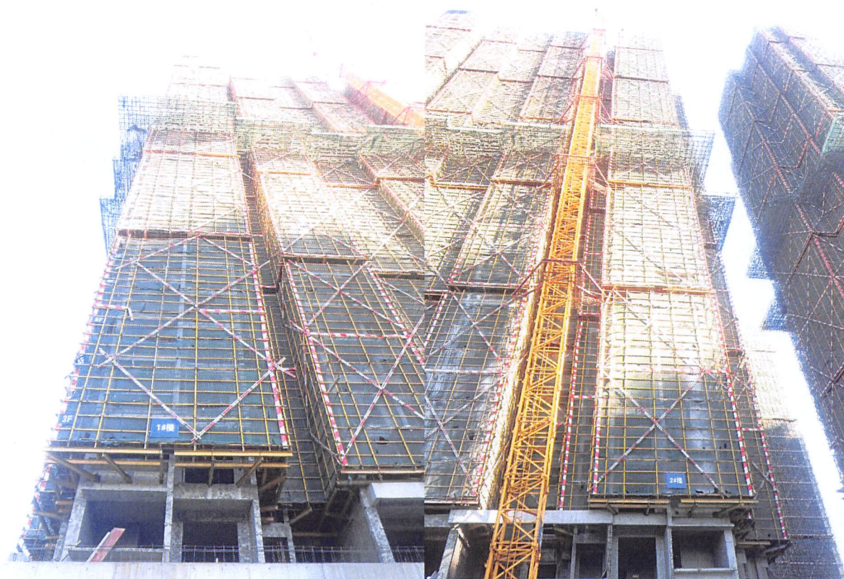
1 栋(内、外墙抹灰分别完成 24 个、23 个楼层)
