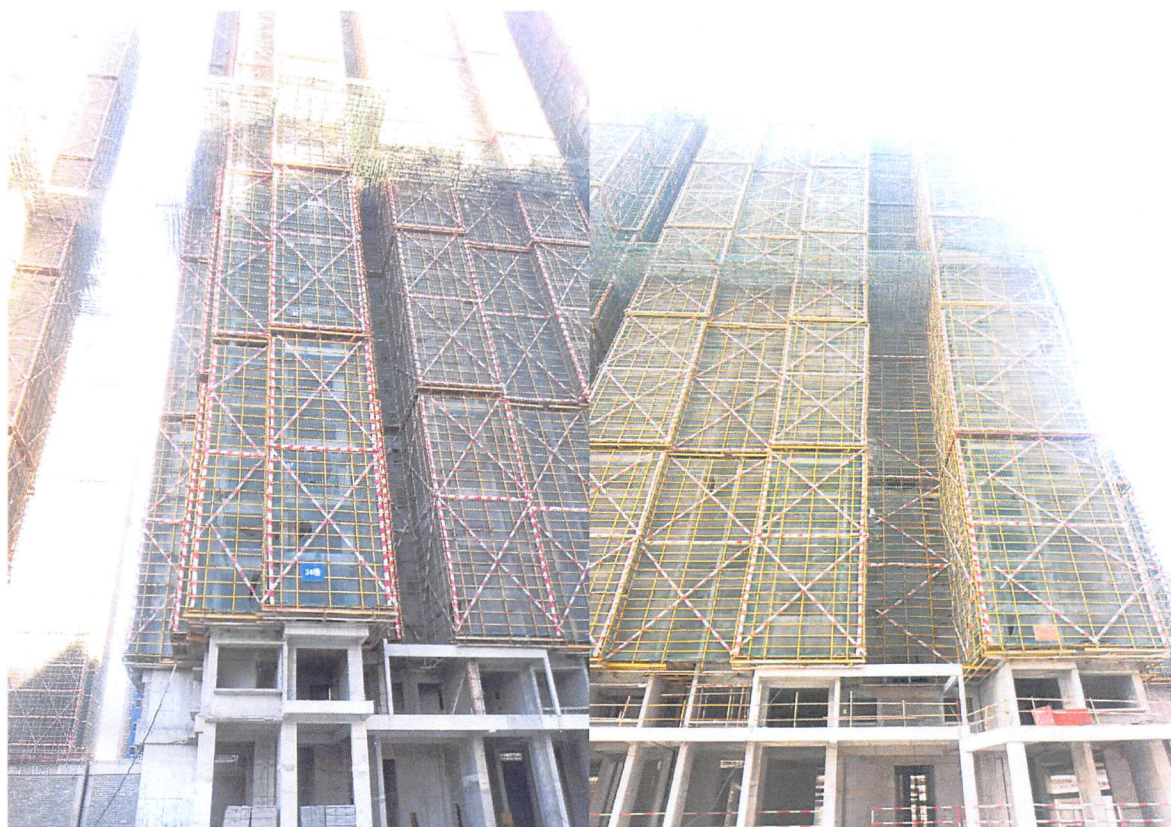
3 栋(内、外墙抹灰分别完成 26 个、26 个楼层)
