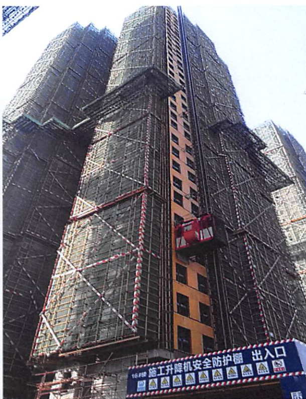
16 栋 (外墙聚合物防水完成 30%)
