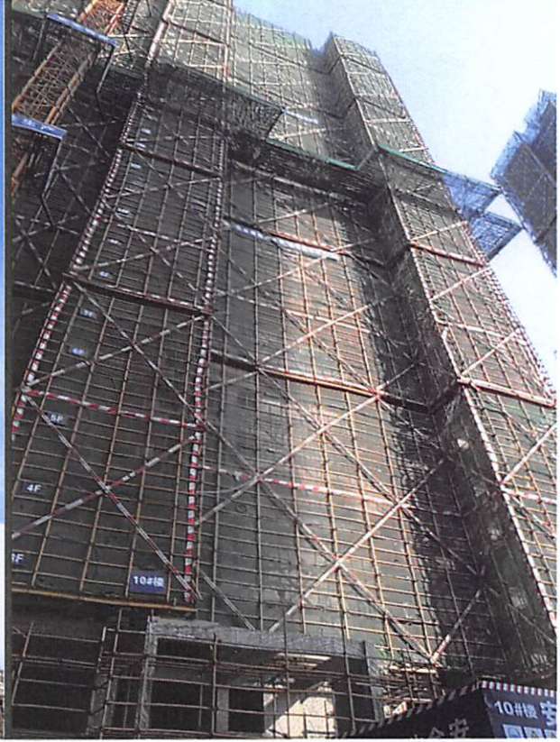
10栋 (9栋外墙聚合物防水完成 85%)
