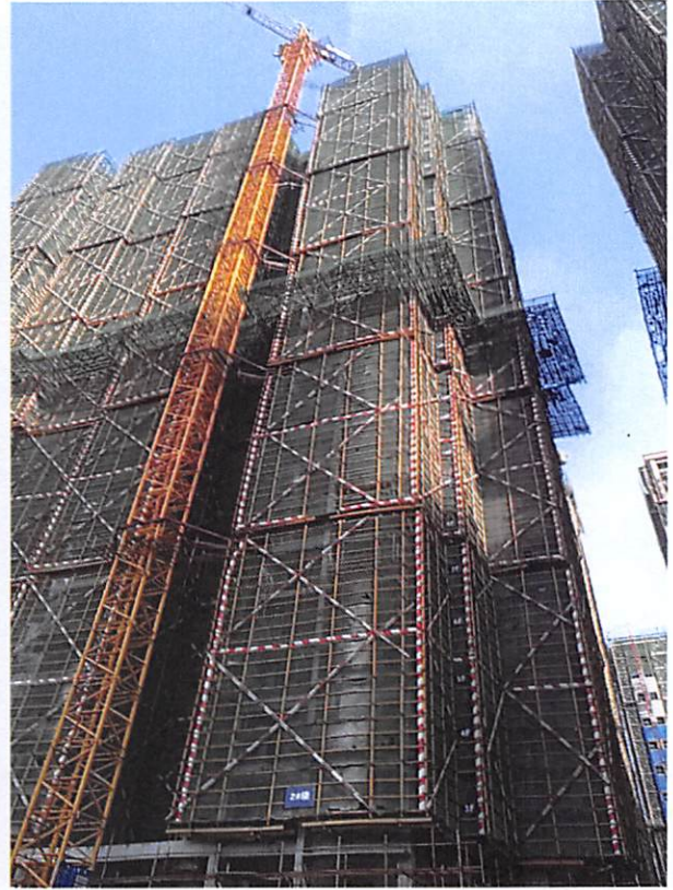
2 栋(外墙聚合物防水完成 30%)
