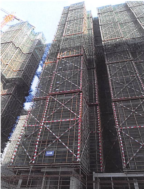
3 栋(外墙聚合物防水完成 30%)
