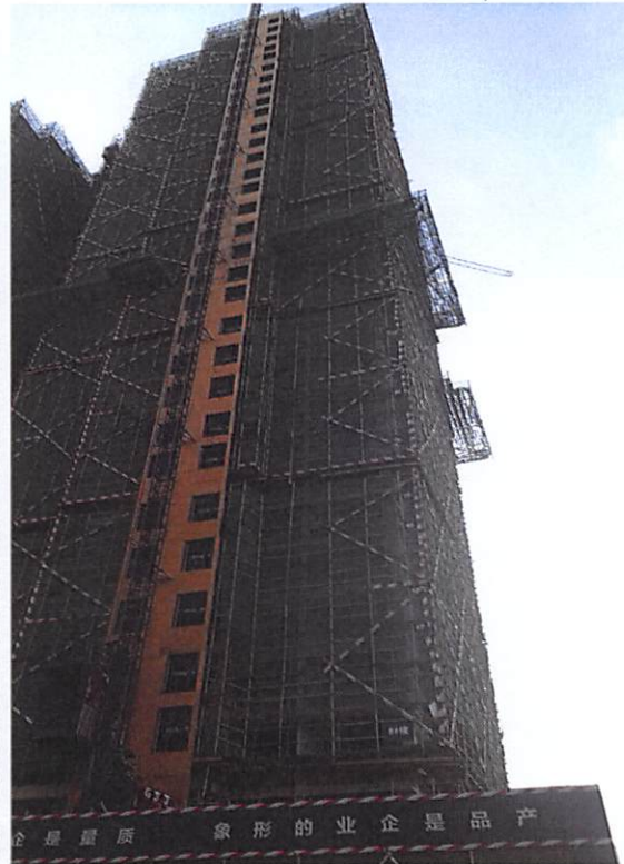
8 栋 (外墙聚合物防水完成 80%)
