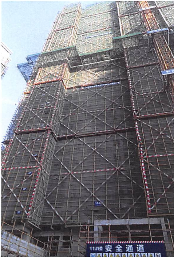
11栋 (9栋外墙聚合物防水完成 85%)
