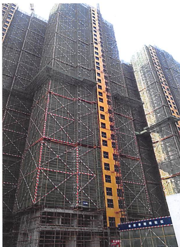
15 栋 (外墙聚合物防水完成 40%)
