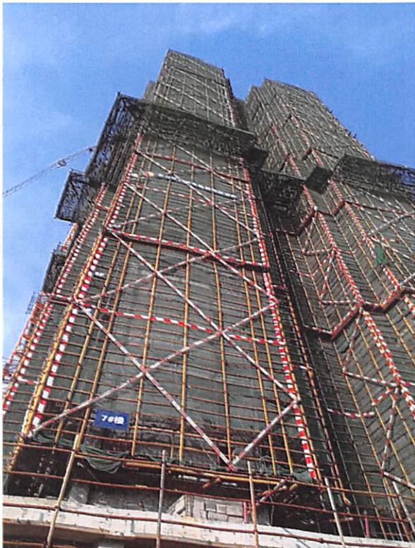
7 栋 (外墙聚合物防水完成 10%)
