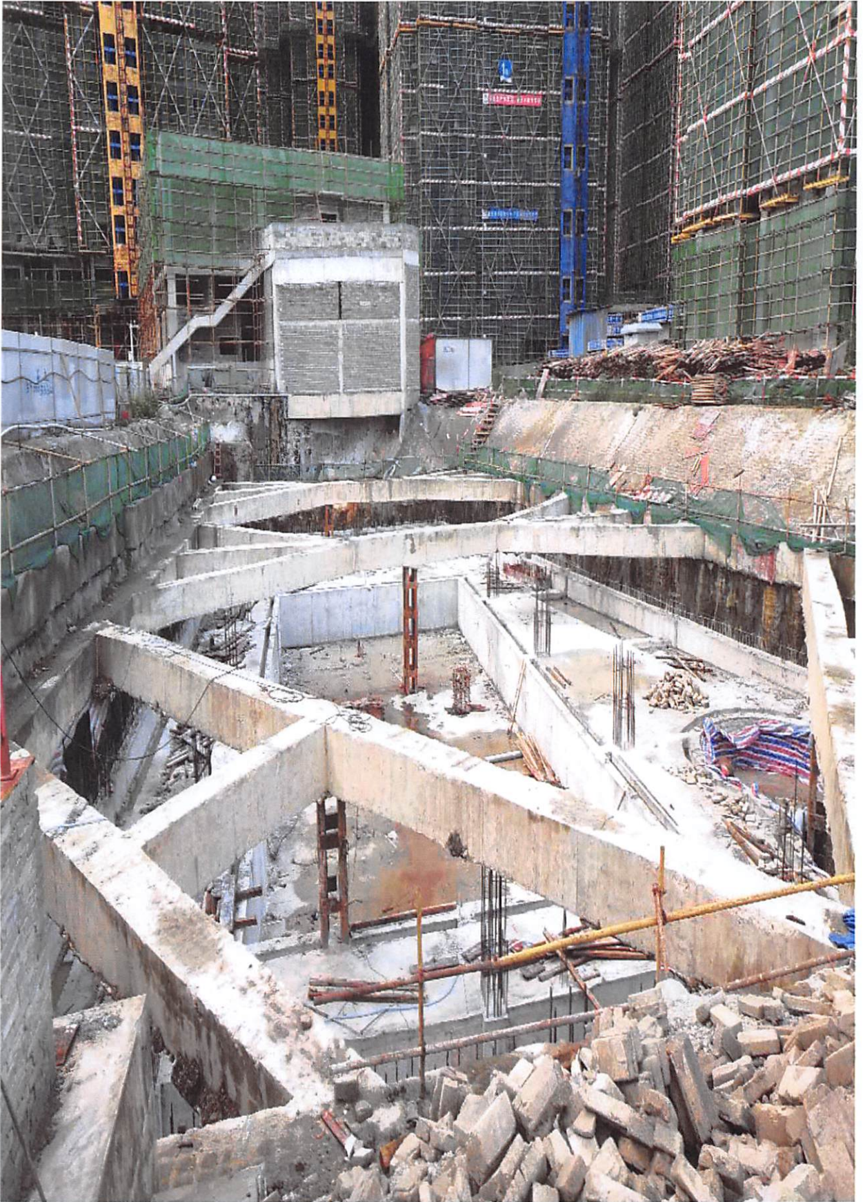
综合楼：地下室底板砼浇筑完成。
