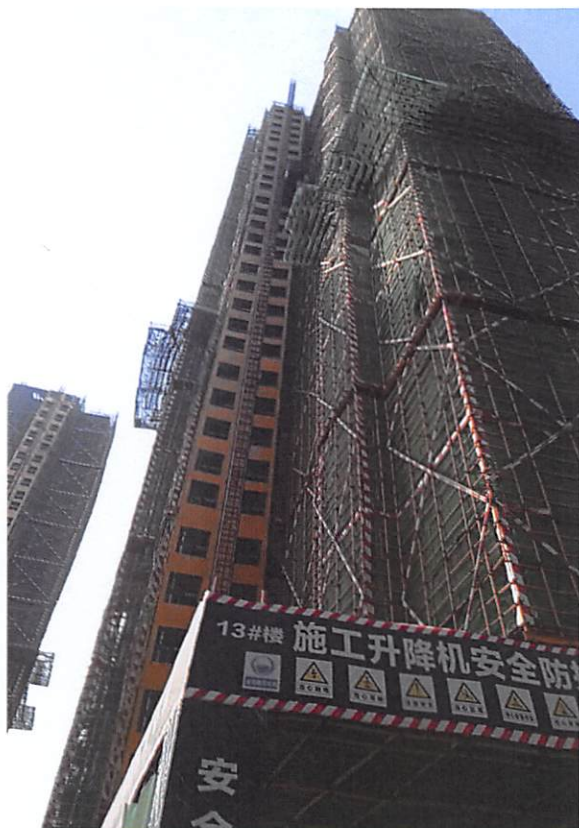
13 栋 (外墙聚合物防水完成 30%)
