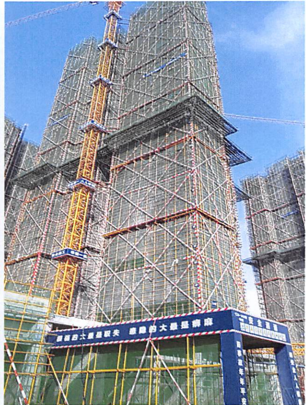
12栋 (9栋外墙聚合物防水完成 20%)
