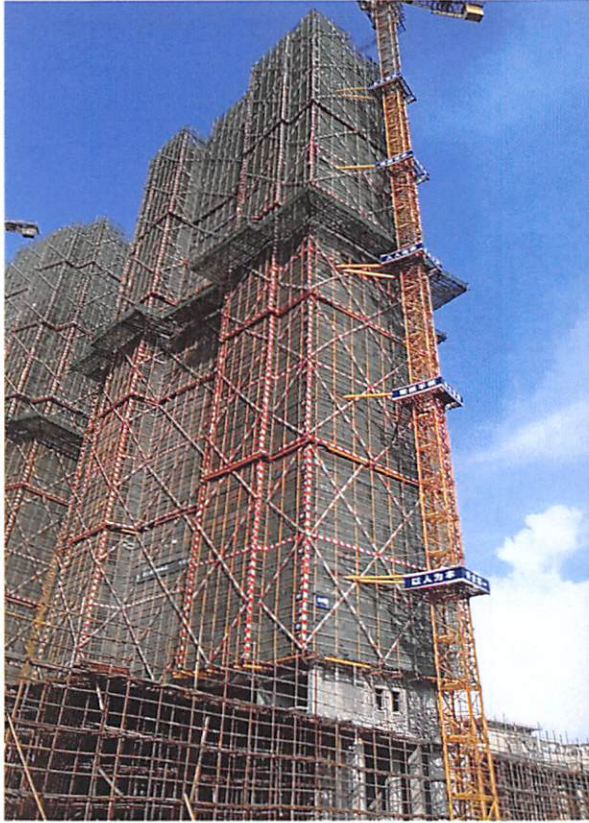
9栋 (9栋外墙聚合物防水完成 30%)
