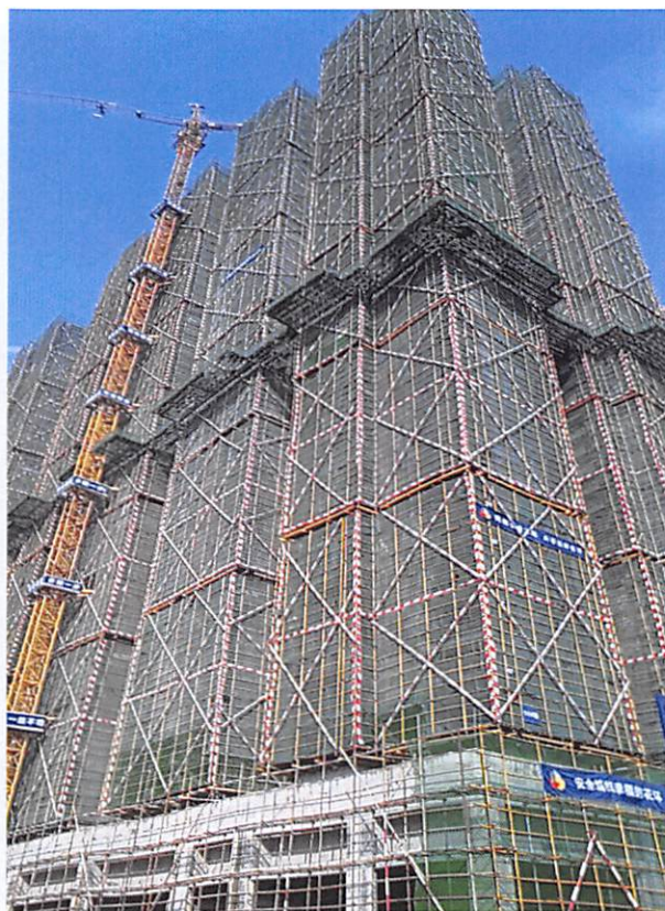
14 栋 (外墙聚合物防水完成 30%)
