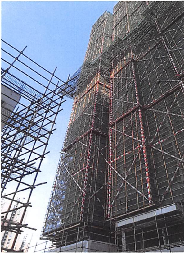
1 栋(外墙聚合物防水完成 10%)
