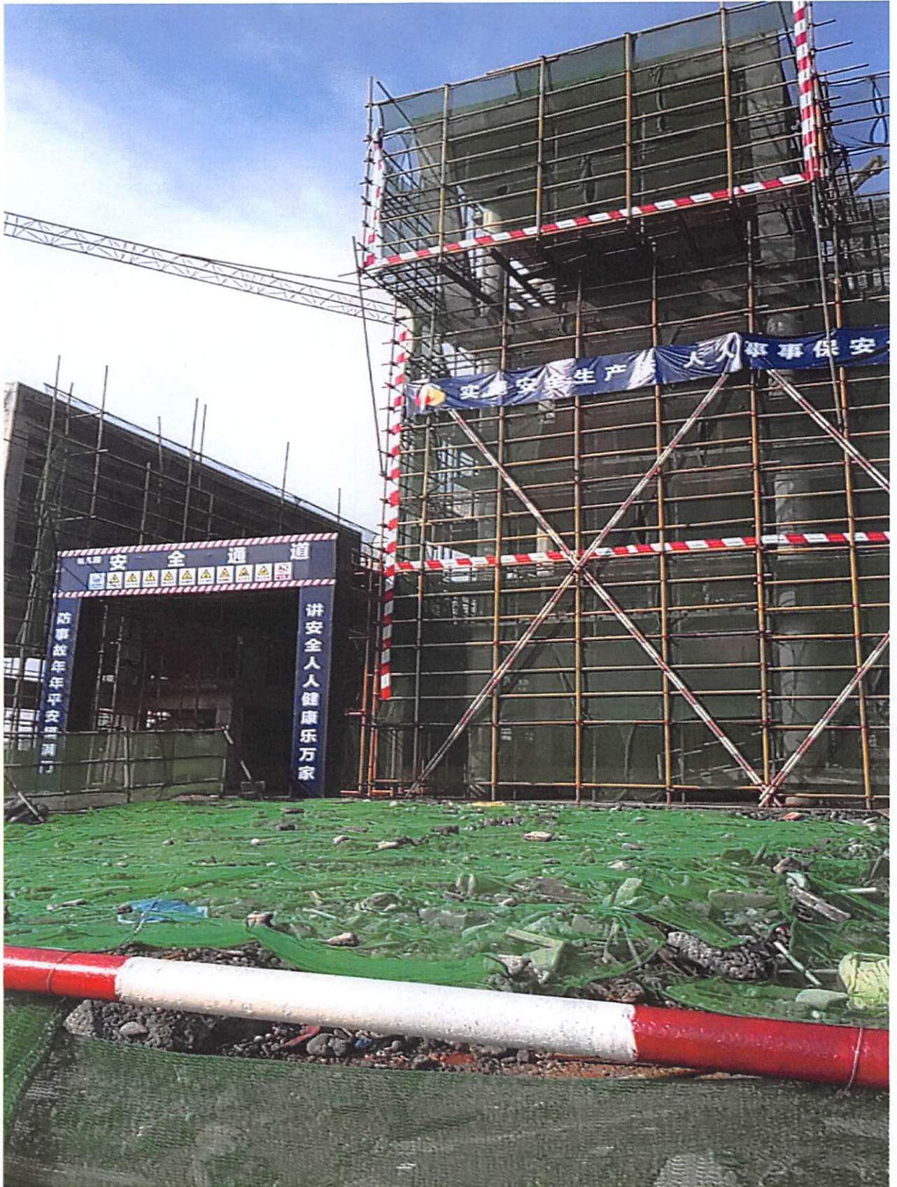
1#商铺墙体砌筑基本完成 30%，2#商铺备砖准备砌筑；幼儿园墙体砌筑完成 30%。
