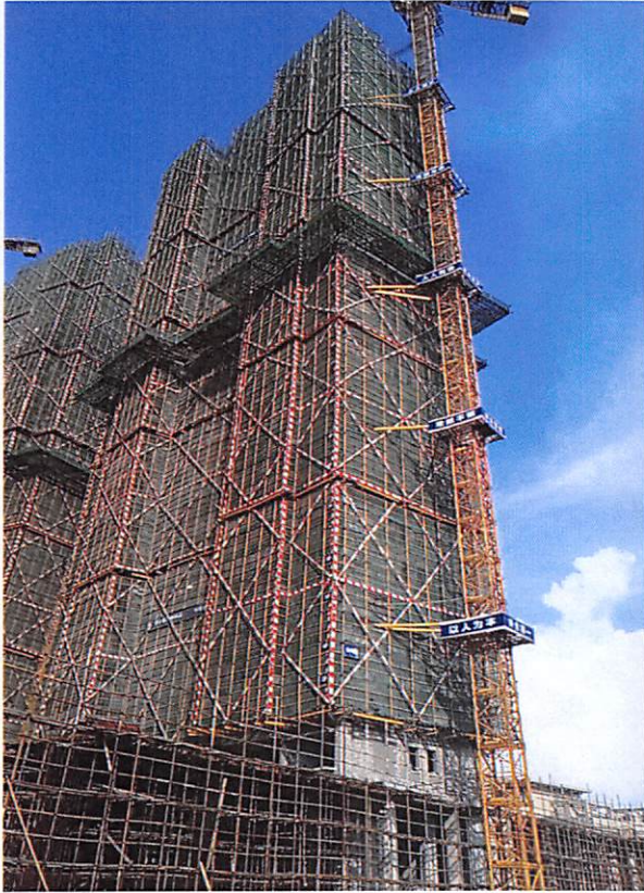
9 栋 (外墙防水 50%, 外墙砖粘贴 20%)
