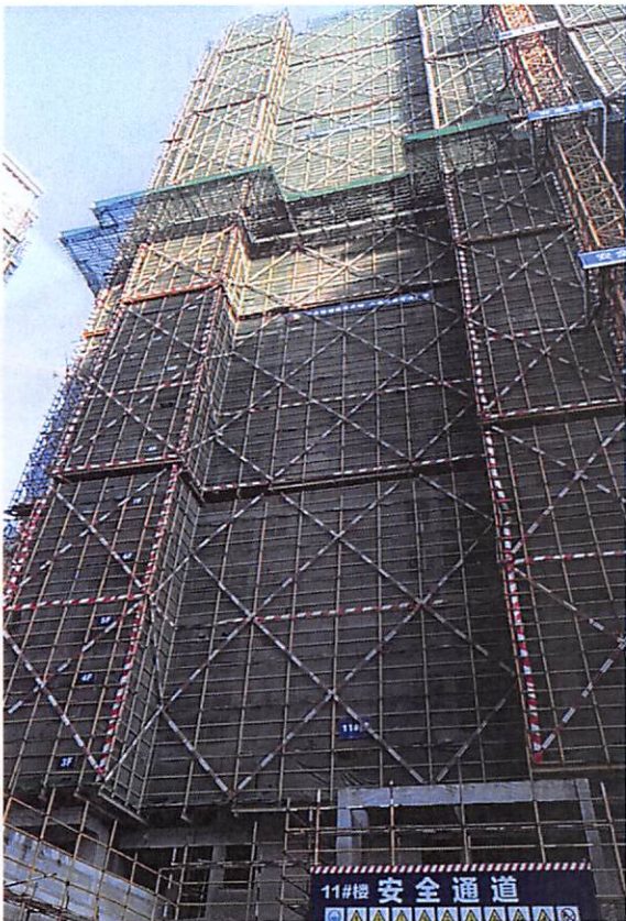
11 栋 (外墙防水 90%, 外墙砖粘贴 25%)
