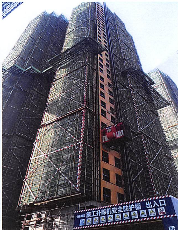
16栋 (外墙防水 40%, 外墙砖粘贴 30%)
