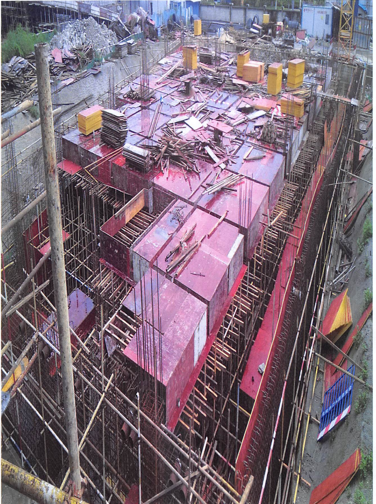
综合楼：地下室顶板模板安装完成 60%，侧壁钢筋绑扎基本完成。
