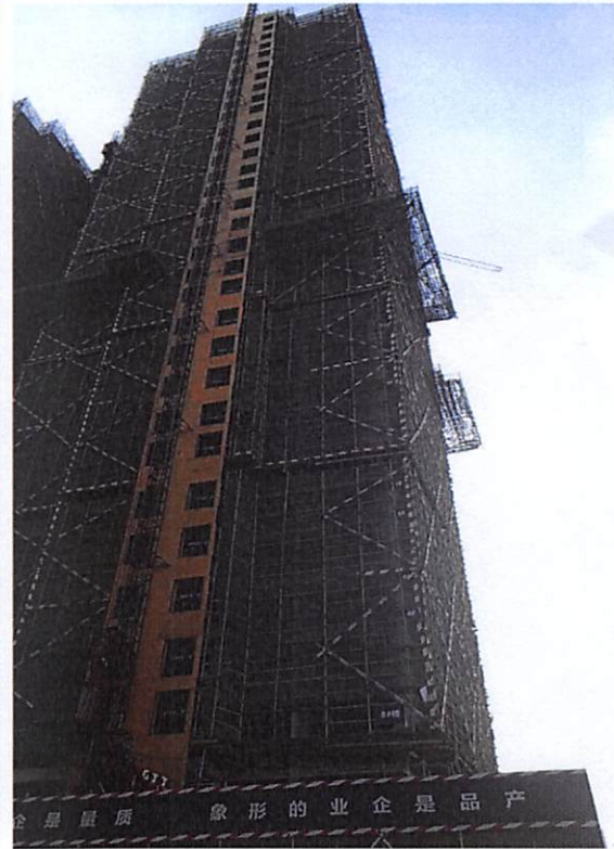
8栋 (外墙防水 95%, 外墙砖粘贴 25%)
