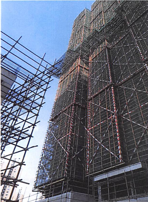
1 栋(外墙防水 70%，外墙砖粘贴 30%)
