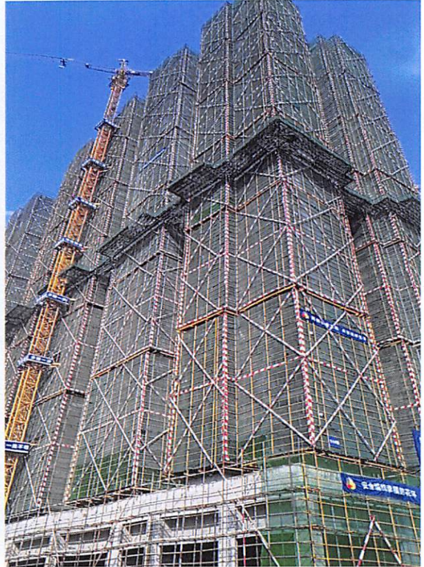
14栋 (外墙防水 95%, 外墙砖粘贴 15%)
