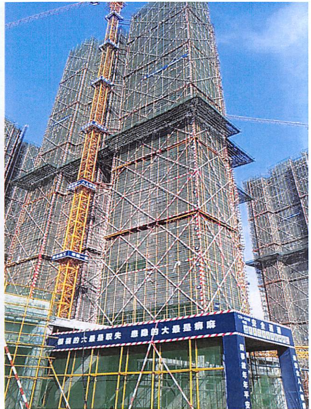
12 栋 (外墙防水 30%, 外墙砖粘贴 5%)
