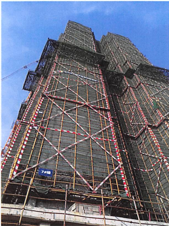
7栋 (外墙防水 45%, 外墙砖粘贴 25%)
