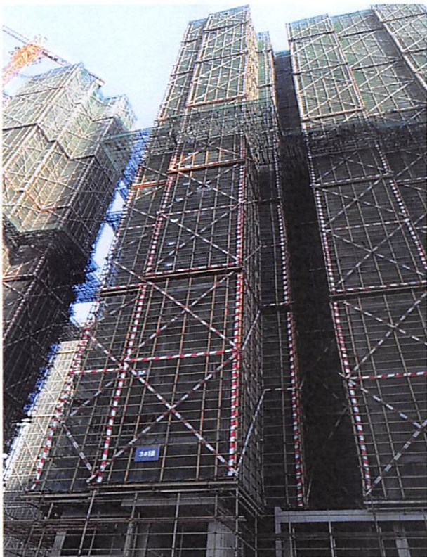
3 栋(外墙防水 90%，外墙砖粘贴 30%)
