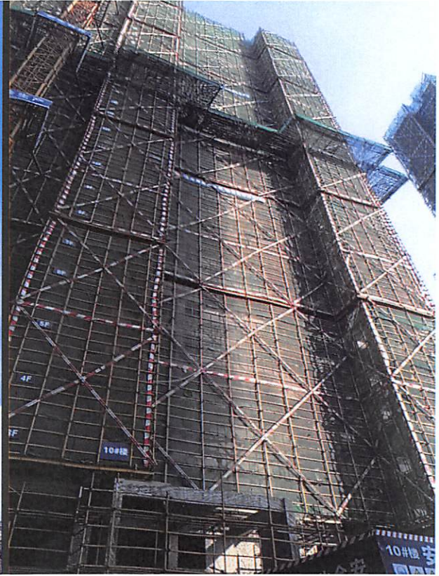
10 栋 (外墙防水 90%, 外墙砖粘贴 25%)
