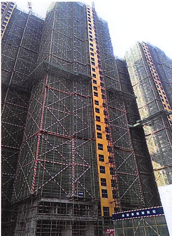
15栋 (外墙防水 95%, 外墙砖粘贴 5%)
