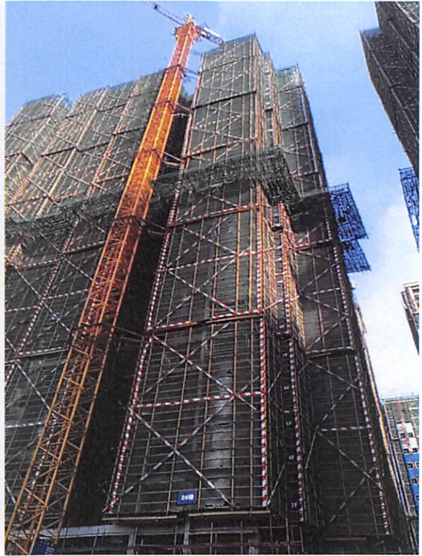
2 栋(外墙防水 70%，外墙砖粘贴 30%)
